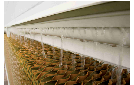
Özel tasarım su yansıtıcı, ped panelin üzerine eşit miktarda su dağıtılmasını sağlar.
