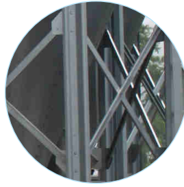
23 cm ayak genişliği ve çapraz bağlantı sistemi ile sağlam yapı
